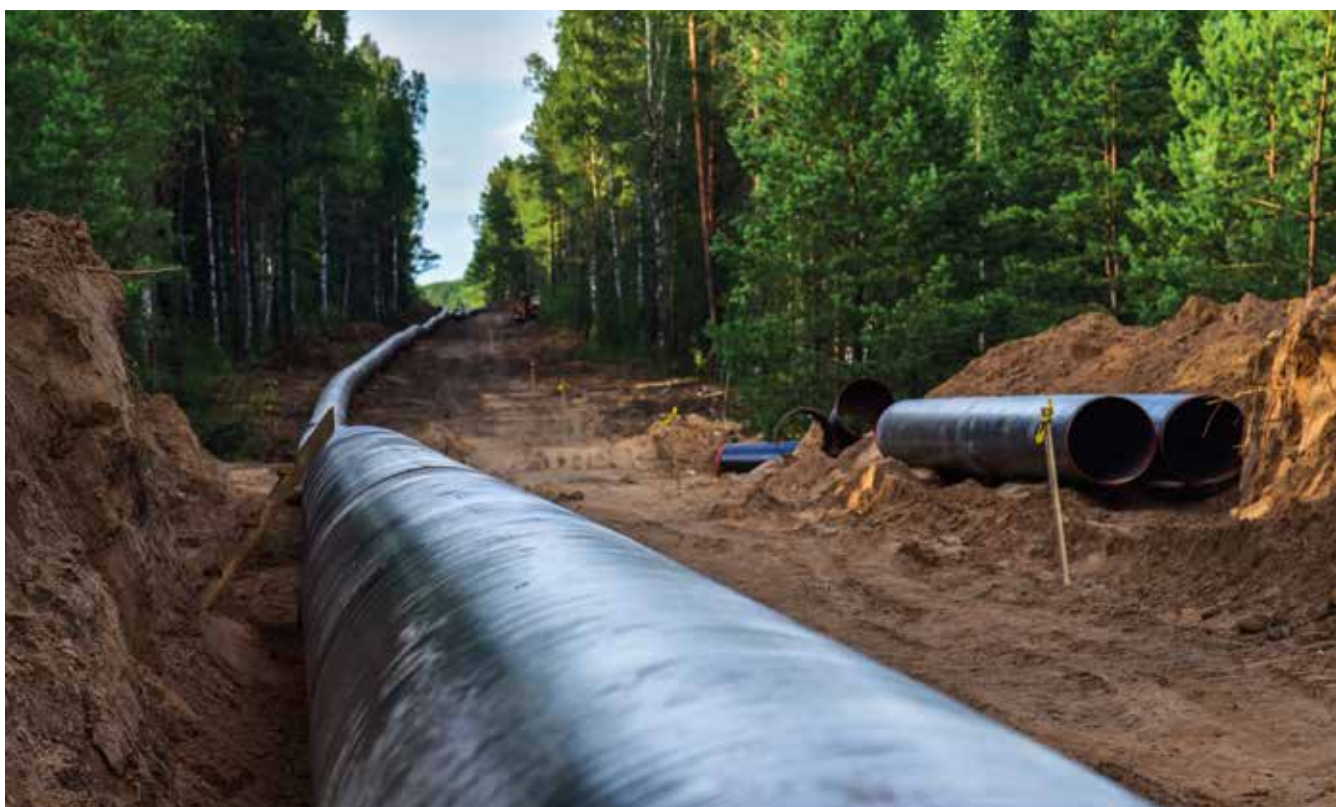
Budowa dużego gazociągu w środku lasu
