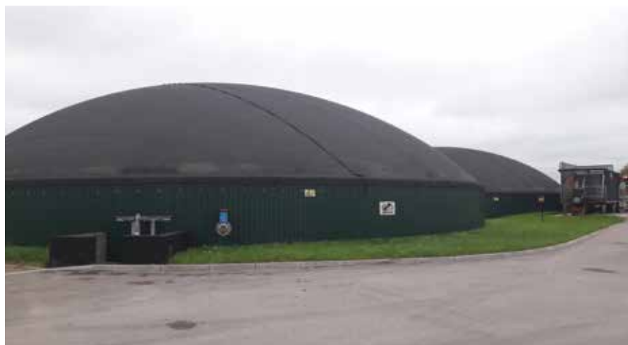
► Planowane jest zwiększenie mocy istniejącej biogazowni rolniczej z 600 kWe do 950 kWe oraz budowa całkowicie nowej biogazowni rolniczej o mocy 600 kWe
